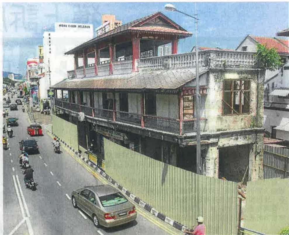
■ “乐台居”原址四周围起围墙，准备进行修复工程。
