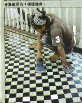
修复后的1楼阳台
